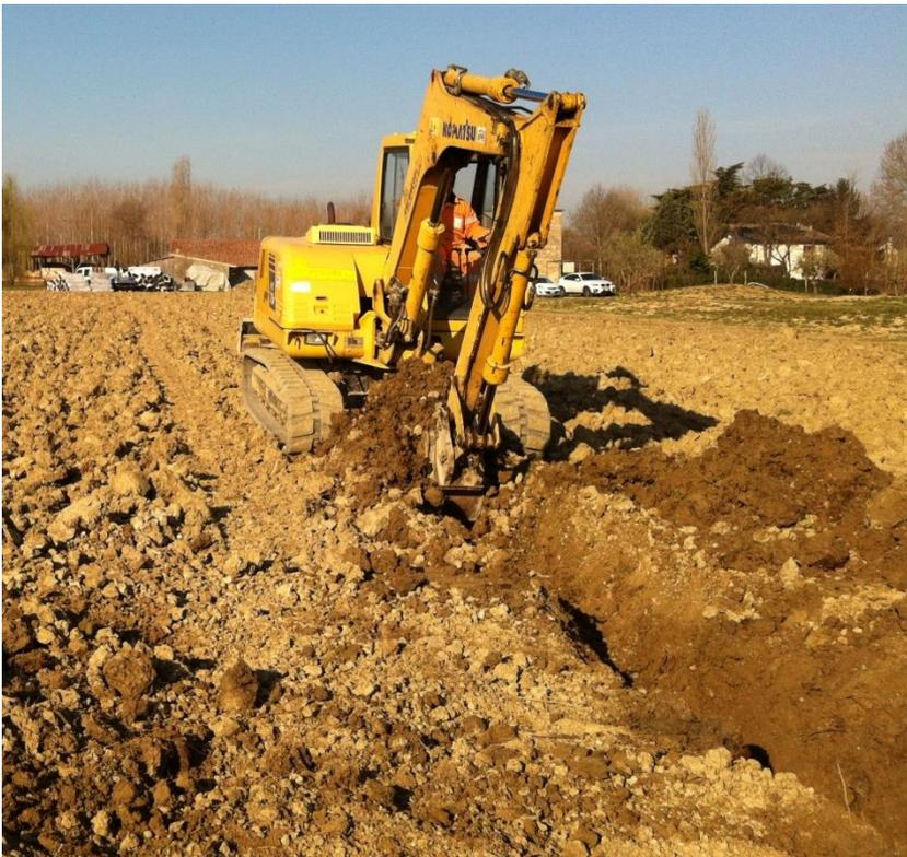
La scelta della benna da 0,40 m è per garantire il mantenimento della sezione ideale dei moduli, che si ricorda avere dimensioni di 0,5 x 0,3 m, una volta calati nella trincea (Fig.1).
