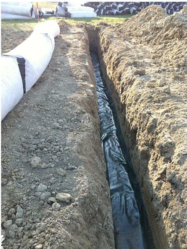
Per garantire la continuità idraulica del dreno, è applicata sul fondo dello scavo una guaina impermeabile, che in questo caso è stata fissata alle pareti con dei chiodi (Fig.2).
