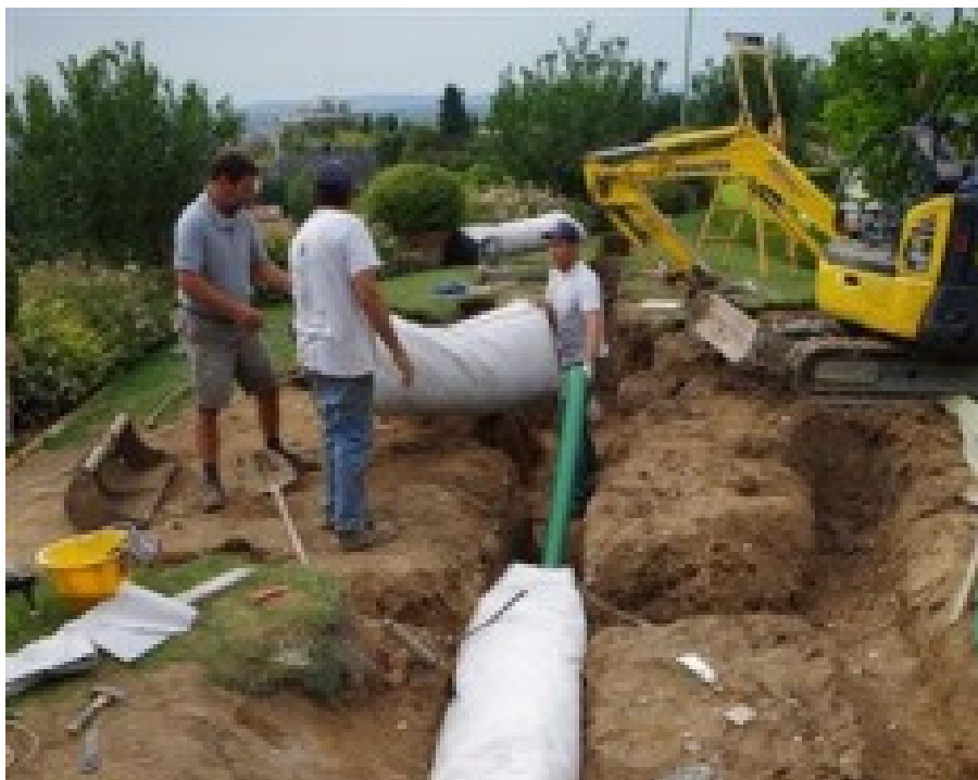
Figura 4. Giunzione dei moduli IDROSAC IMHOFF
