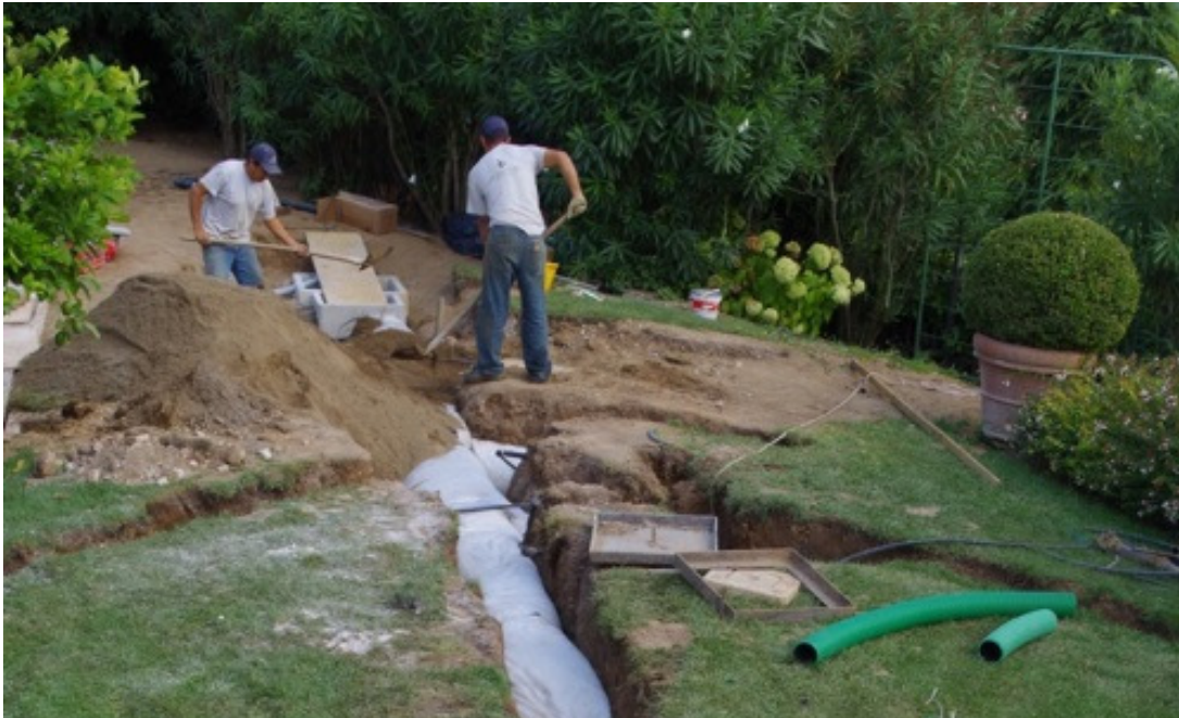
Figura 7. Copertura del sistema con sabbia
