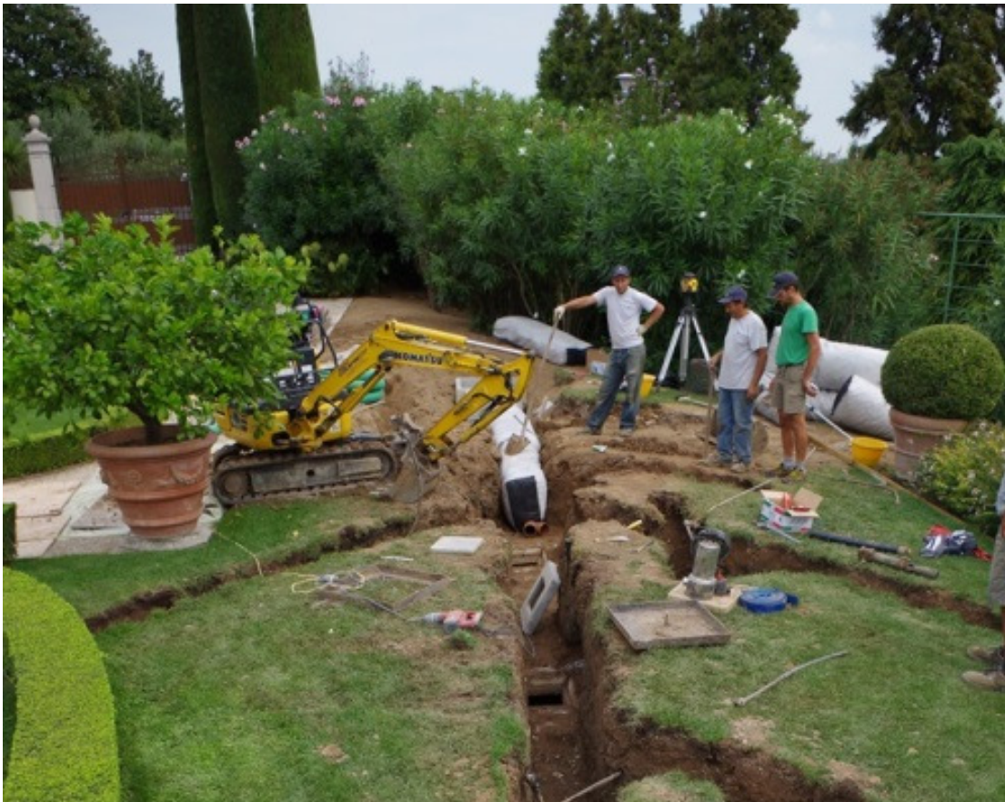
Figura 3. Escavatore meccanico utilizzato per effettuare lo scavo
