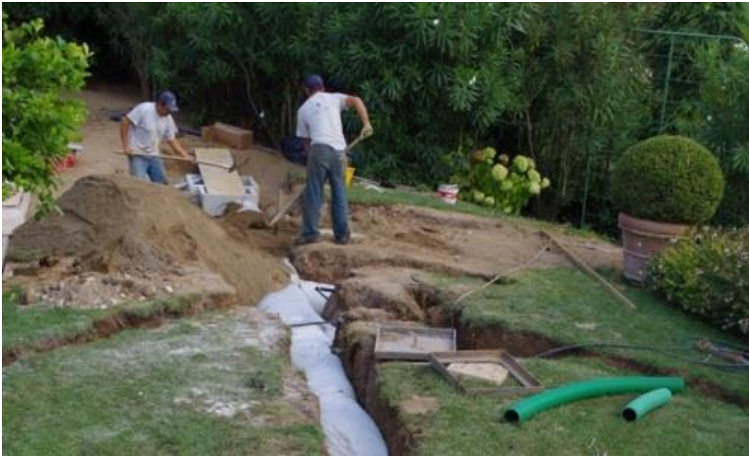
Figura 7. Copertura del sistema con sabbia
