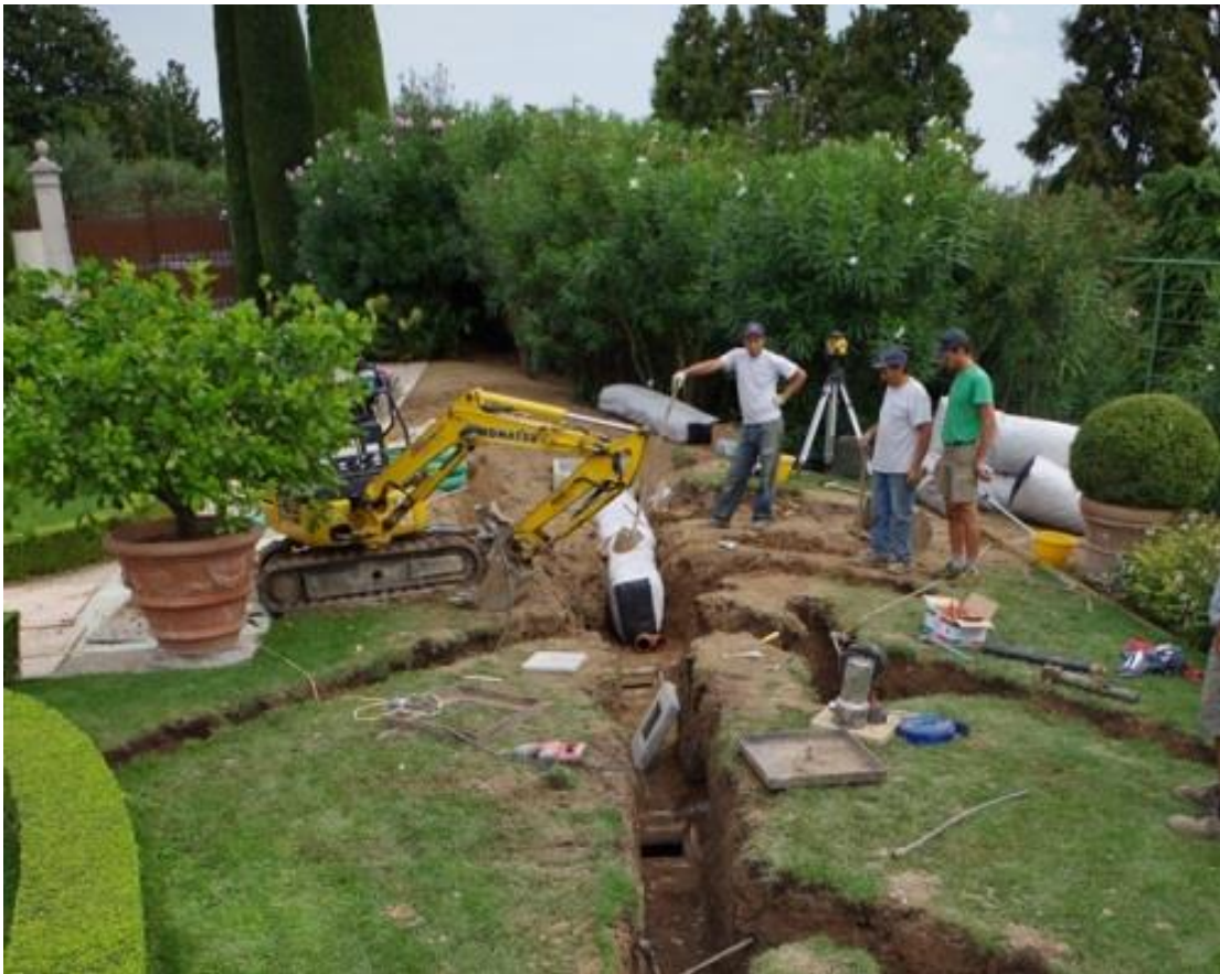
Figura 3. Escavatore meccanico adoperato per effettuare lo scavo
