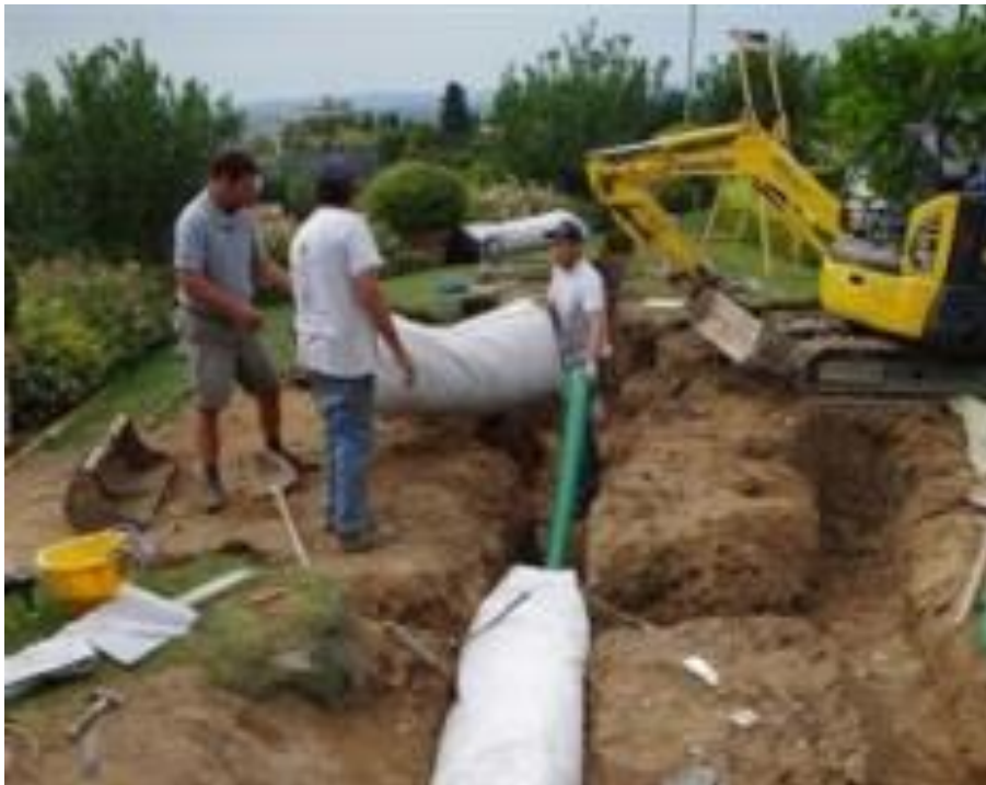
Figura 4. Giunzione dei moduli IDROSAC IMHOFF
